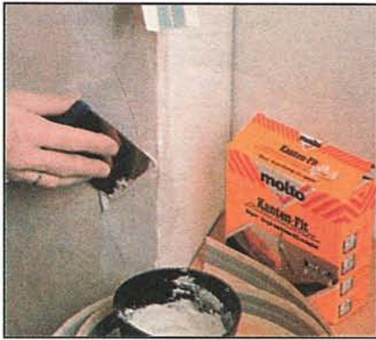
Наружные углы оштукатуренной кирпичной кладки можно быстро восстановить, установив на угол оцинкованный уголок и зашпатлевав его.
