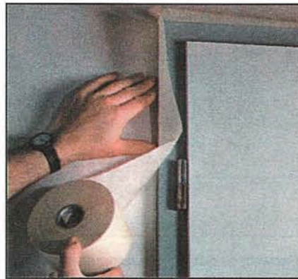
Эта односторонняя малярная лента предназначена для защиты протяжённых элементов, например, наличников и оконных рам.
