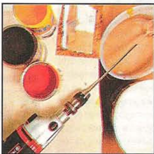
Цветную краску добавляют мелкими порциями и размешивают миксерной насадкой для дрели.
