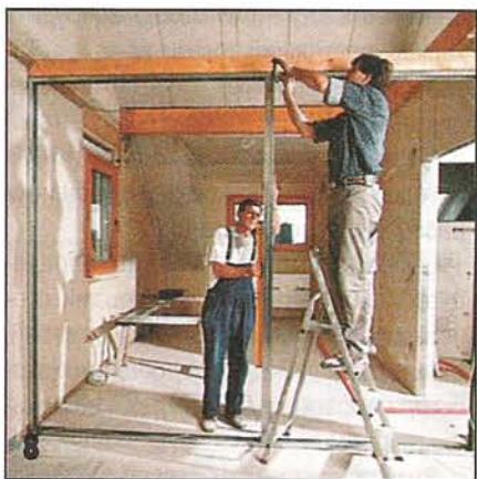
В качестве вспомогательного конструктивного элемента между напольным и потолочным профилями устанавливают вплотную друг к другу «спиной к спине» и скрепляют болтами две стойки.
