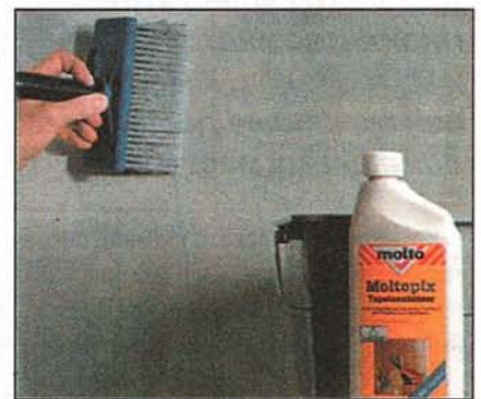
Жидкое средство для снятия обоев годится для удаления старого клевого покрытия.
