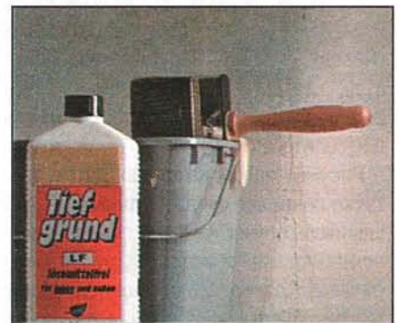
Перед окрашиванием дисперсионными красками, оштукатуриванием и облицовкой плиткой основу покрывают специальной грунтовкой.
