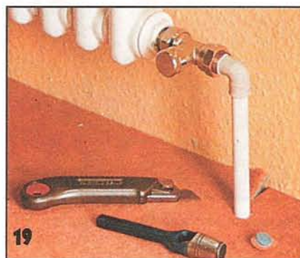
19 Для труб и ножек отопительных батарей в покрытии сначала высекают пробойником круглые отверстия, а затем разрезают покрытие от отверстия до края.
