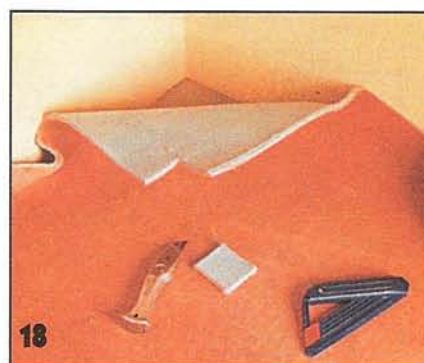
18 У внутренних углов помещения в углу покрытия вырезают небольшой квадрат, причём так, чтобы остриё выреза совместилось с вершиной угла пола. Затем края покрытия напускают на стены и обрезают вдоль линии перехода между стенами и полом.
