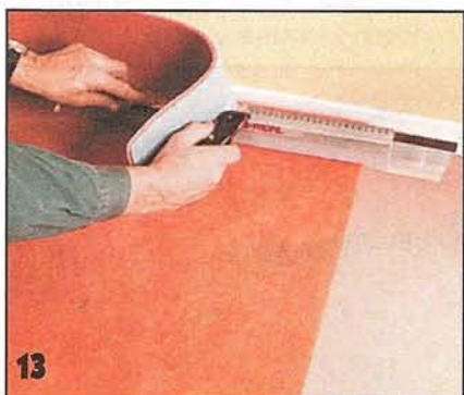
13 На переходах между стеной и полом ковровое покрытие можно обрезать ножом с помощью уголковой шины, которую применяют для обрезки у пола и потолка наклеиваемых обоев.
