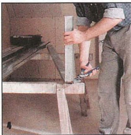
Если требуются вставки, их выкраивают из профилей ножницами по металлу.
